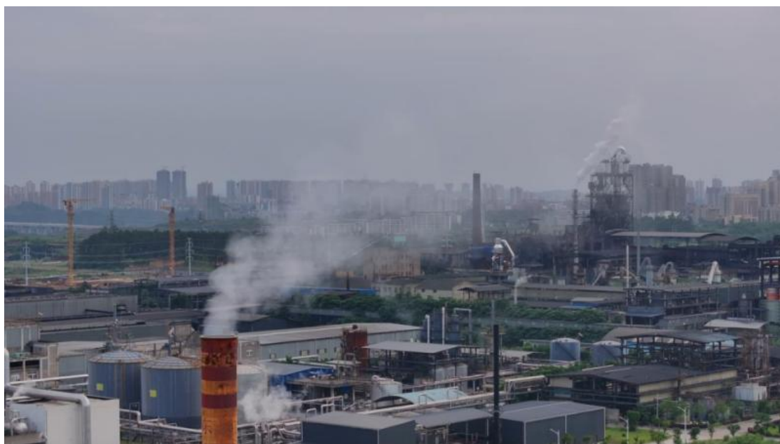
图 4 2024 年 5 月 31 日，督察组现场督察发现，潼南工业园区北区废气排放扰民问题突出
