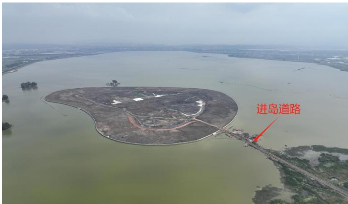
图4 2024年5月21日，督察组现场督察发现，大屯海内建成一座42万平方米人工岛
