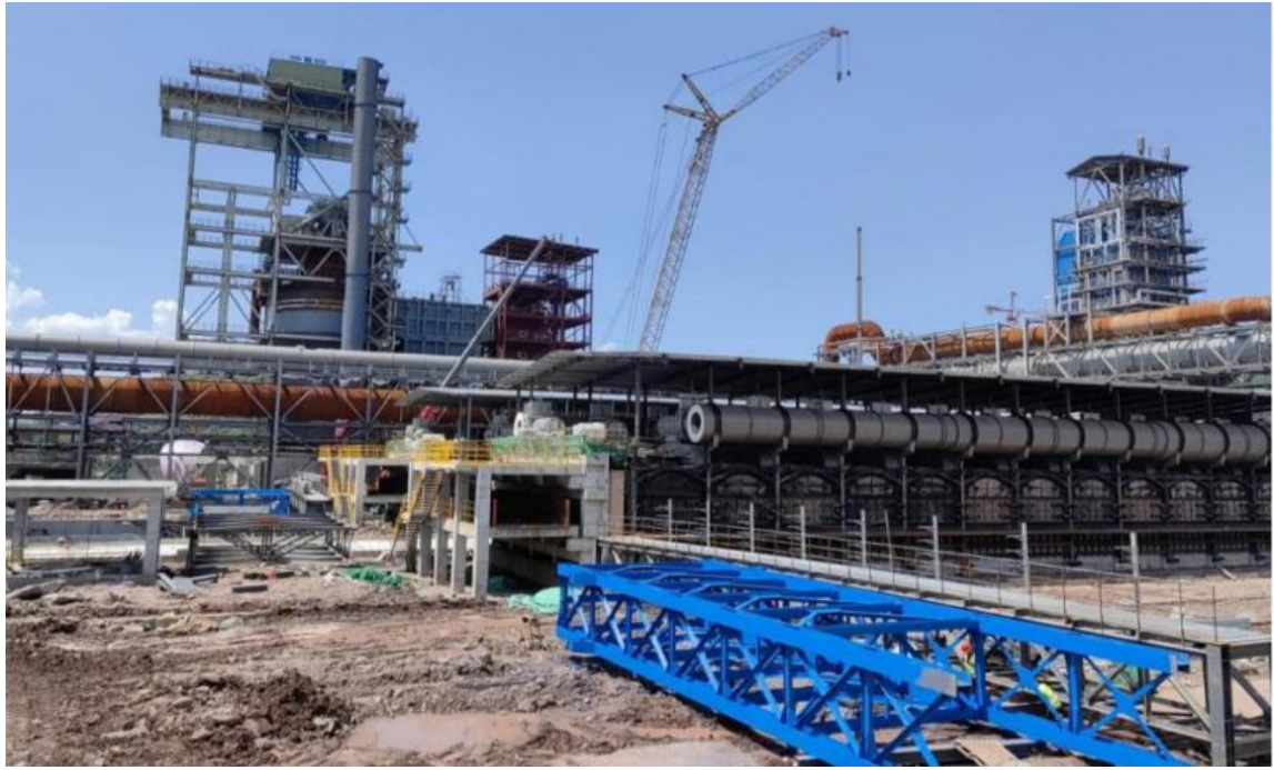
图 1 2024 年 5 月 22 日，督察组现场督察发现，涪陵区科尔科克新材料有限公司 150 万吨/年焦电一体化项目主体装置已基本建成，但产能置换指标仍未落实
