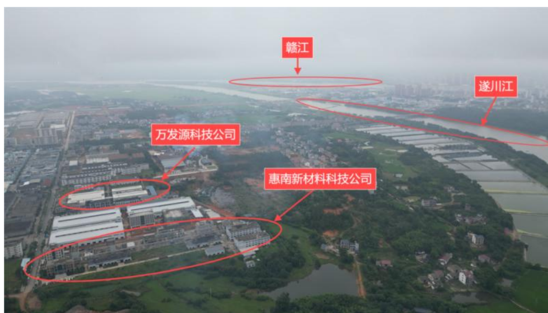
图 1 2024 年 5 月 31 日，督察组现场督察发现，2019 年以来吉安市万安工业园在长江二级支流遂川江 1 公里范围内新建 2 个化工项目
