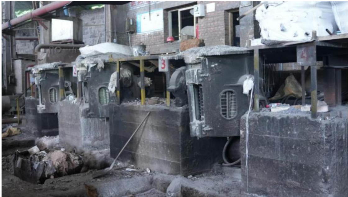
图3 2024年5月31日，督察组现场督察发现，綦江区綦齿高新铸造有限责任公司列入淘汰类设备的无磁轭铝壳电炉仍在使用
