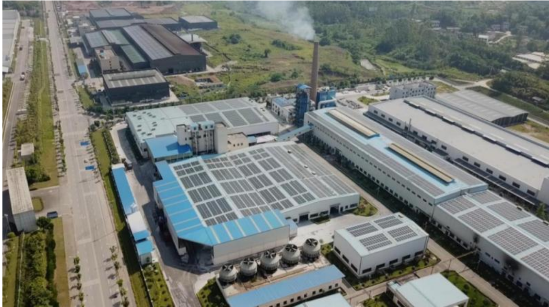
图 2 2024 年 5 月 22 日，督察组现场督察发现，垫江县金富源新材料有限公司 350 吨/天电子级超薄浮法玻璃生产线项目在未落实产能置换指标情况下已点火投产
