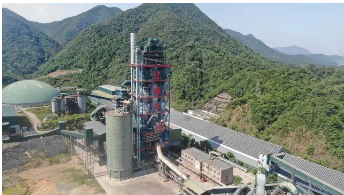
图 4 2024 年 5 月 18 日，督察组现场调阅生产台账发现，2024 年 2 月 10—11 日黄色预警期间，杭州市桐庐县红狮水泥有限公司未落实应急预案要求的限产措施
